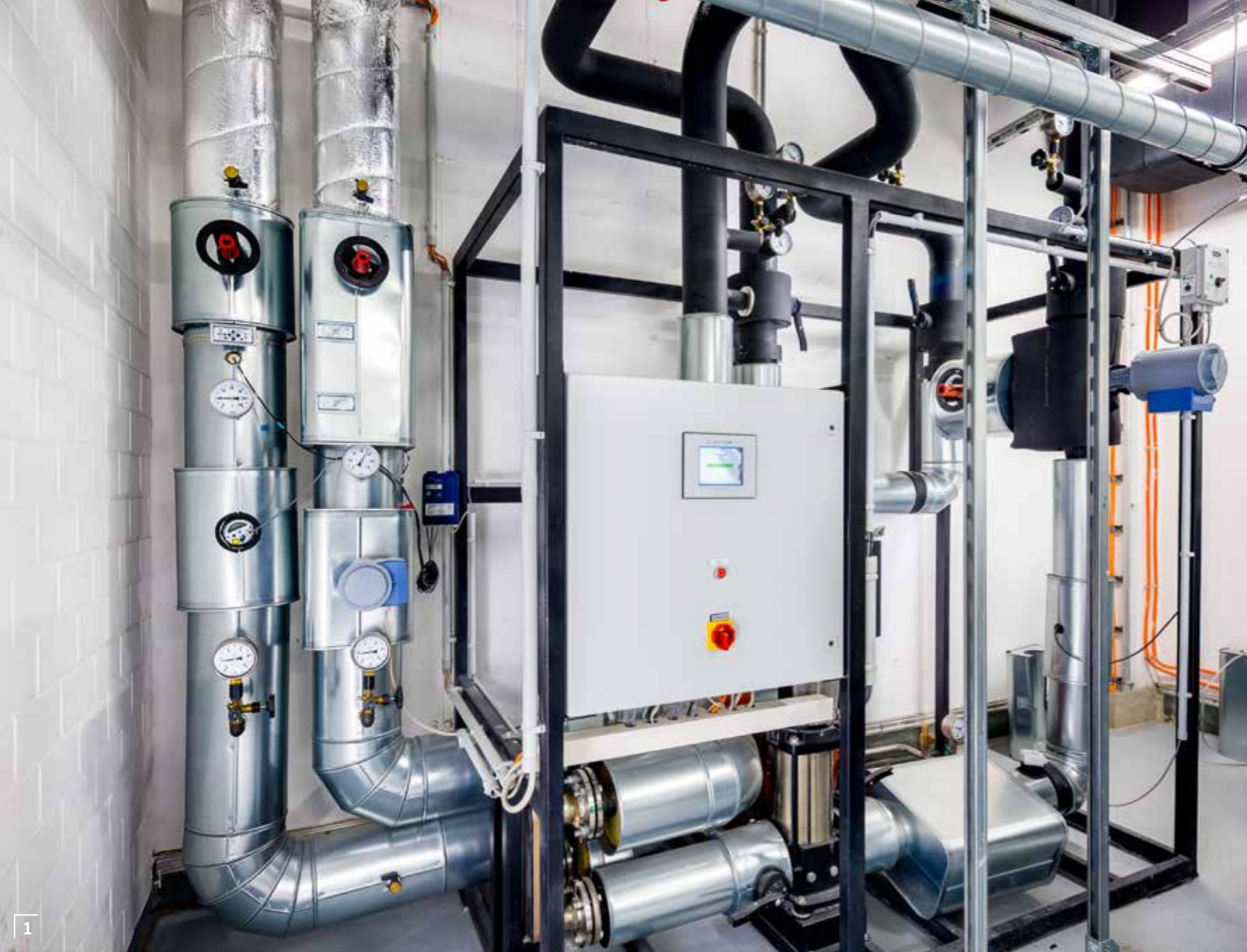
1 // Hocheffizientes Wärmerückgewinnungssystem EcoCond als Kreislaufverbund mit integrierter Wärmespeicherung 2 + 3 // Klimazentralgerät für Büroklimatisierung mit Hochleistungs-Kreislaufverbundsystem EcoCond
